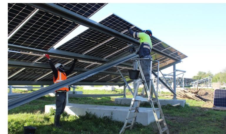
Octobre 2024 : 80% des fondations ont été réalisées. Plus de 20 personnes travaillent au montage des panneaux solaires. Les structures sont basses, la plupart du montage se fait donc à hauteur d'homme. Le câblage vient de débuter.
